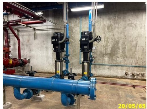
ถังเก็บน้ำ พร้อมเครื่องปั้มน้ำใต้ดิน
