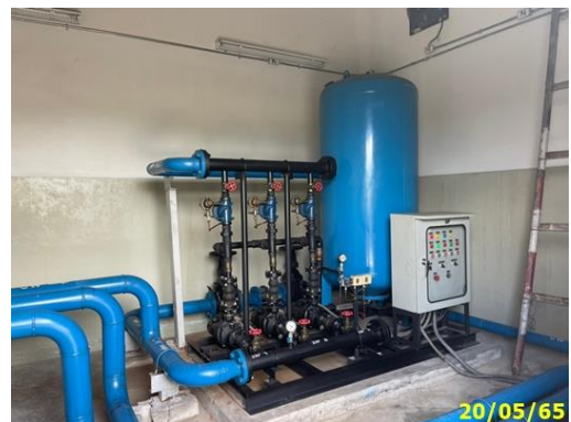
ถังถังเก็บน้ำ พร้อมเครื่องปั้มน้ำขึ้นตาดฟ้า
